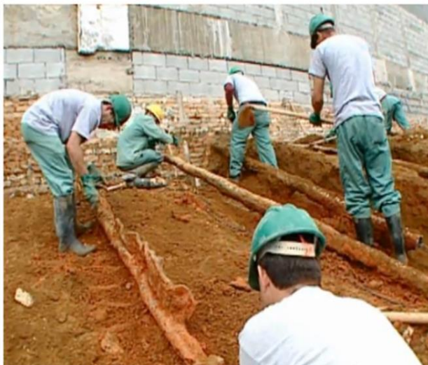
Figura 5. Exumação de grampos executados com reinjeção (Zirlis et al., 2015)
